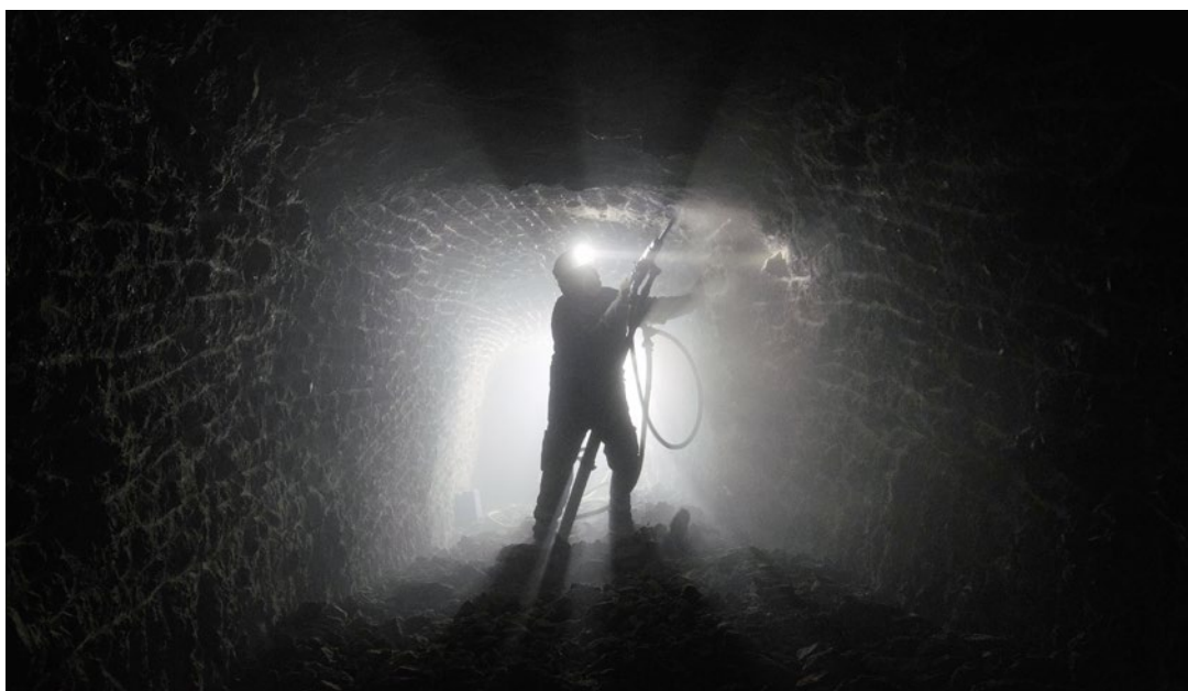
Nachrissarbeiten mit Presslufthammer und Rückzugstütze im Verbindungsschurf zur bronzezeitlichen Fundstelle im Salzbergwerk Hallstatt. Foto: Daniel Brandner / NHM
